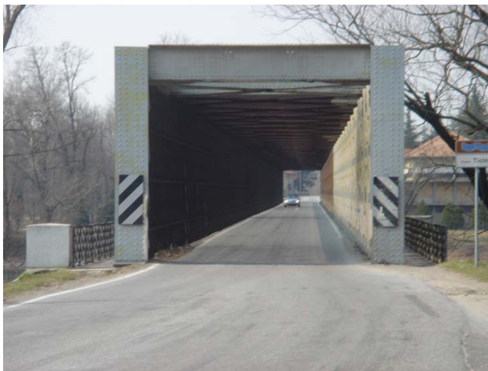
IMBOCCO LATO EST
